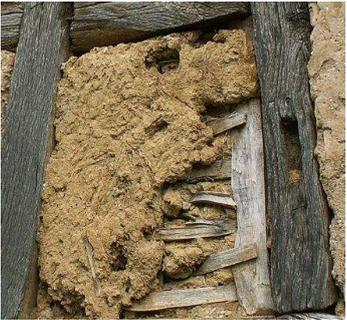
Il sistema a **torchis** è formato da un impasto a granulometria variabile di **acqua, argilla e fibre naturali** (paglia, fieno, fibre vegetali in genere, in alcune aree geografiche si usa anche arricchire l'impasto con sabbia e calce, quest'ultima per rendere impermeabile l'aggregato) con consistenza plastica (semi-fluida)
