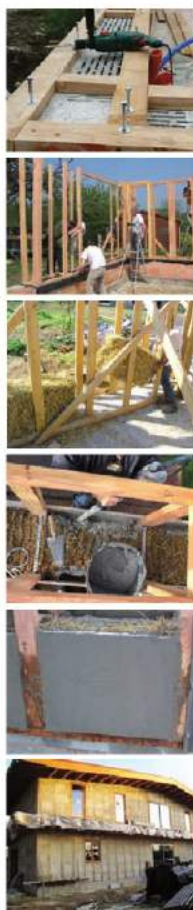
Fig. 4 - Immagini relative alle fasi del sistema costruttivo murario in paglia (Greb).
